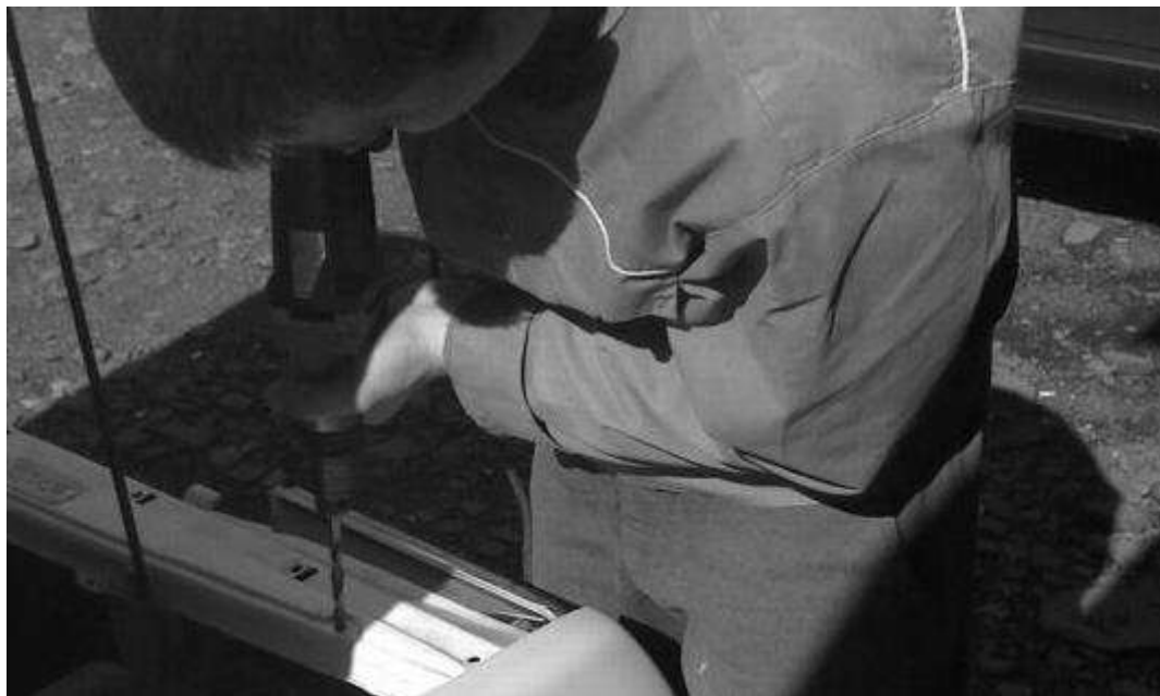
Рисунок 39.1. Прием работы электрической сверлильной машиной.
