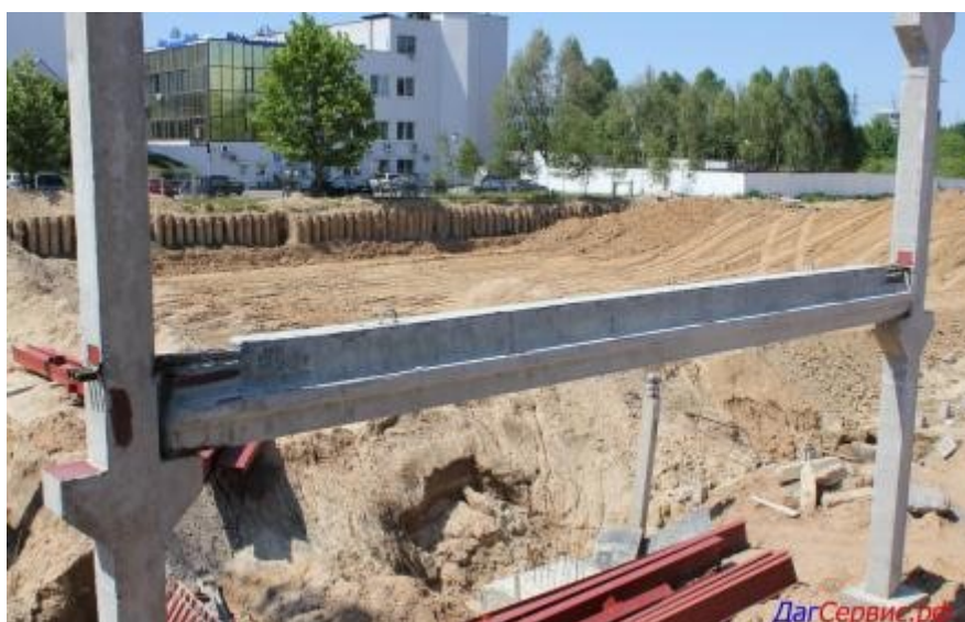
Рисунок 2.2 – Ригель, опора для каркасных строений
