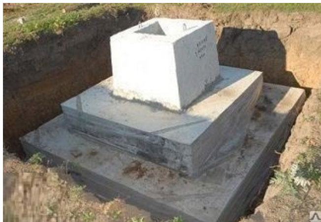
Рисунок 4.1 – Столбчатый фундамент под колонну
