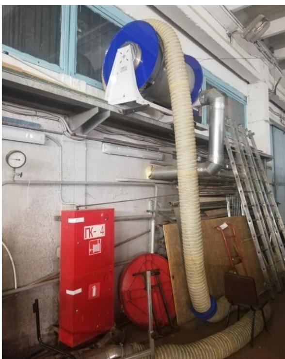
Рисунок 3.15 – Вытяжное устройство для отвода отработавших газов
