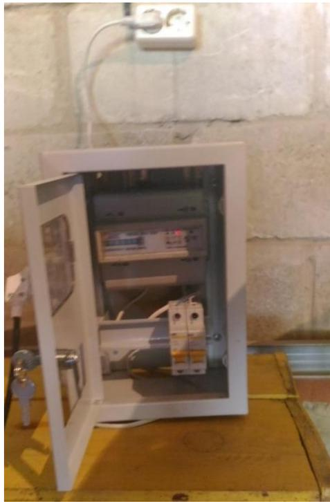
Рисунок 4.9– Электрощиток с трехфазным счетчиком электрической энергии НИВА304 1SO
