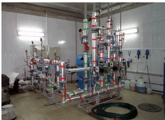
Рисунок 4 – Автоматизированный тепловой пункт
