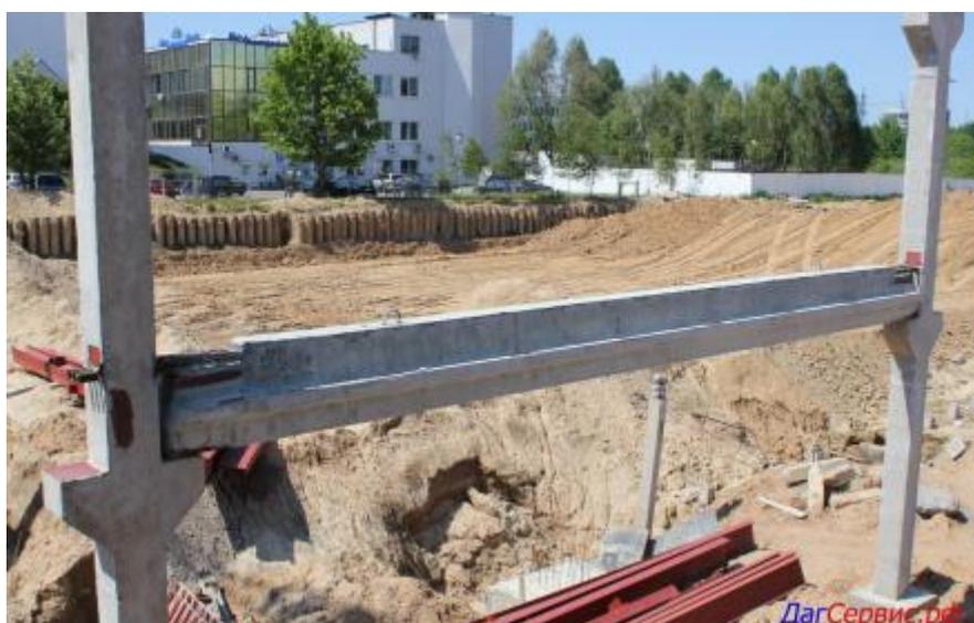
Рисунок 2.2 – Ригель, опора для каркасных строений
