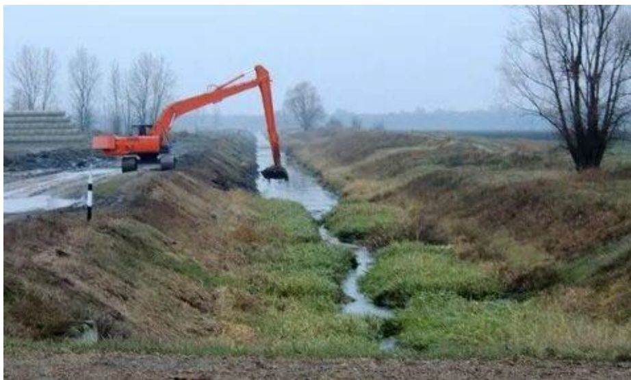
Рисунок 1 – Очистка откосов мелиоративных каналов от растительности
