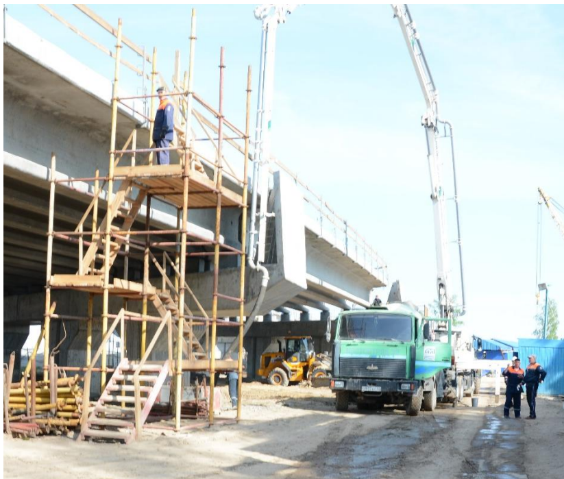
Рисунок 2 – Фрагмент строительства транспортной развязки (фото автора)
