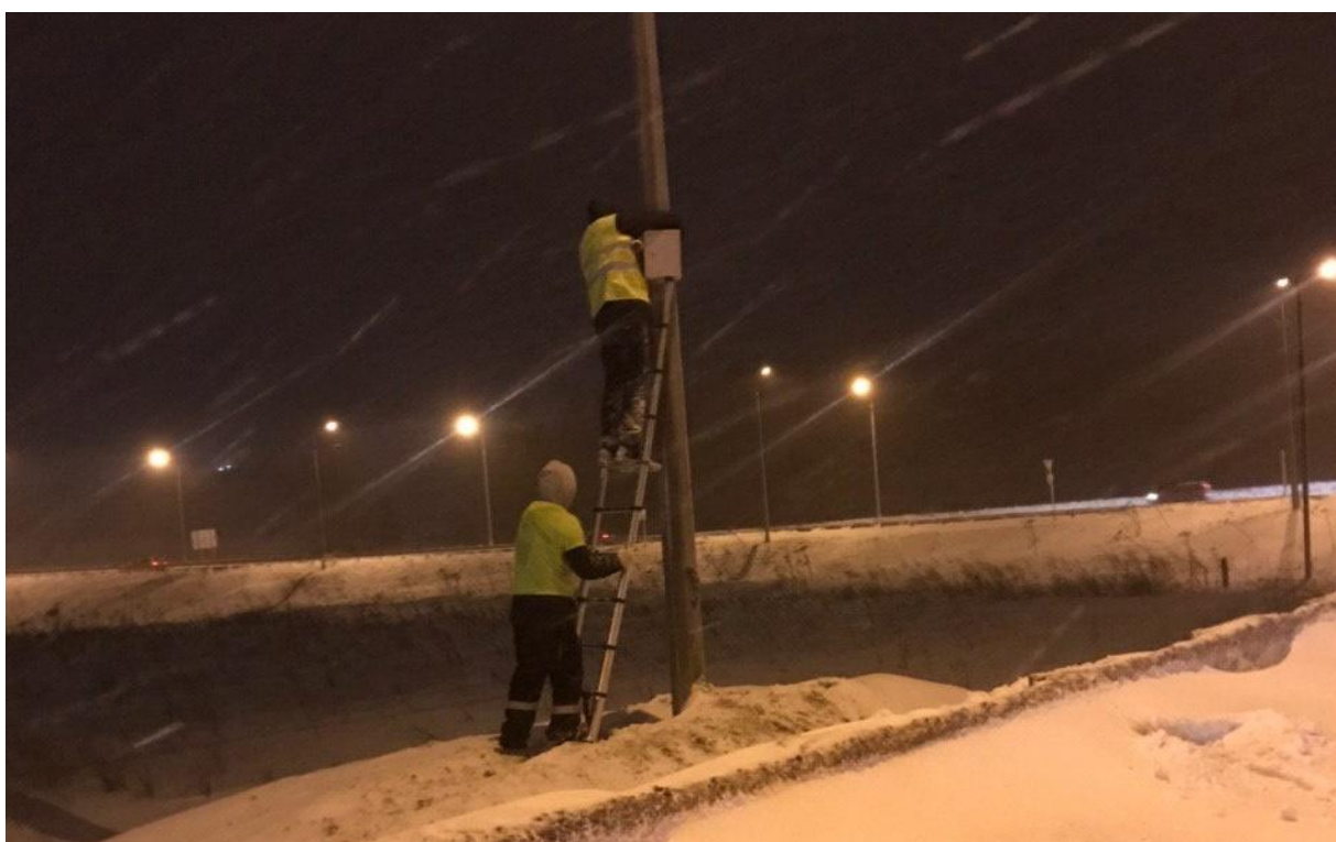
Рисунок 1 – Установка камеры на точке замера
