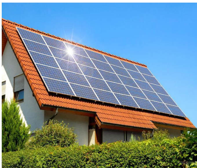
Рисунок 2 – Солнечная батарея на кровле загородного дома
