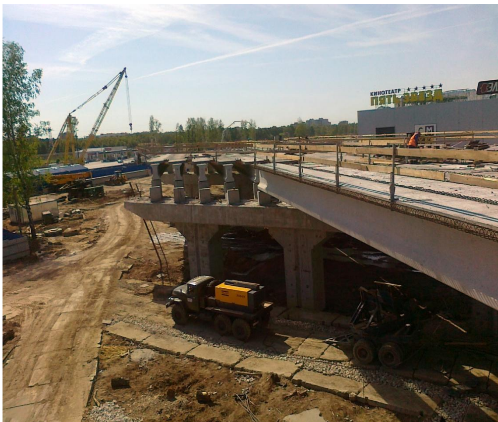
Рисунок 3 – Строительство развязки (фото автора)
