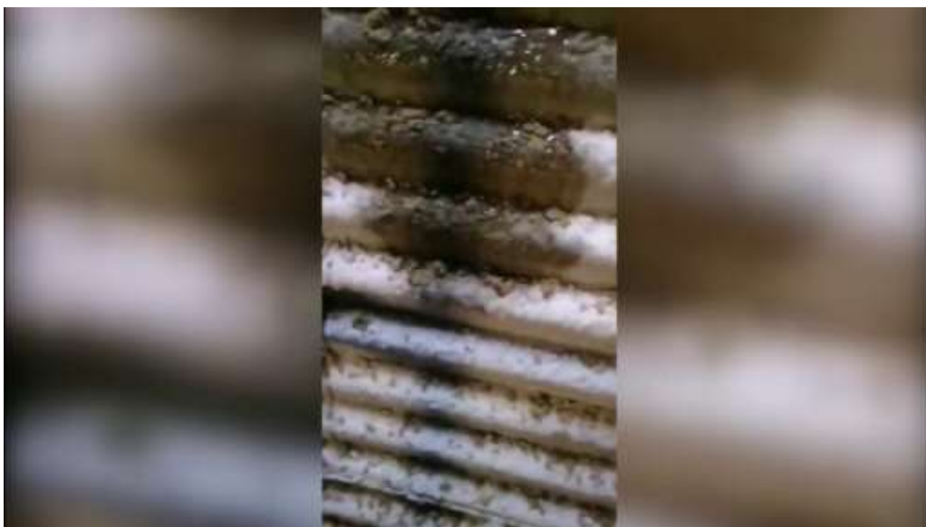
Рисунок 1 – Пример отпотевания зерна в металлическом силосе
