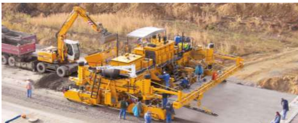
Рисунок 3 – Укладка бетонной смеси при помощи специального оборудования
