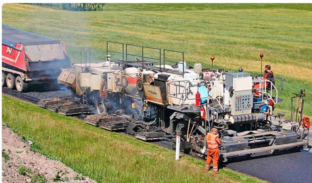
Рисунок 3 – Ремонта дорожного полотна
