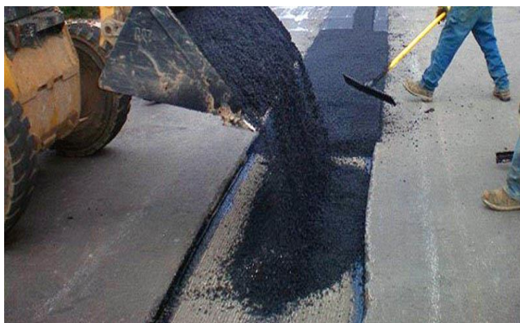
Рисунок 3 – Ямочный ремонт с применением холодного асфальта
