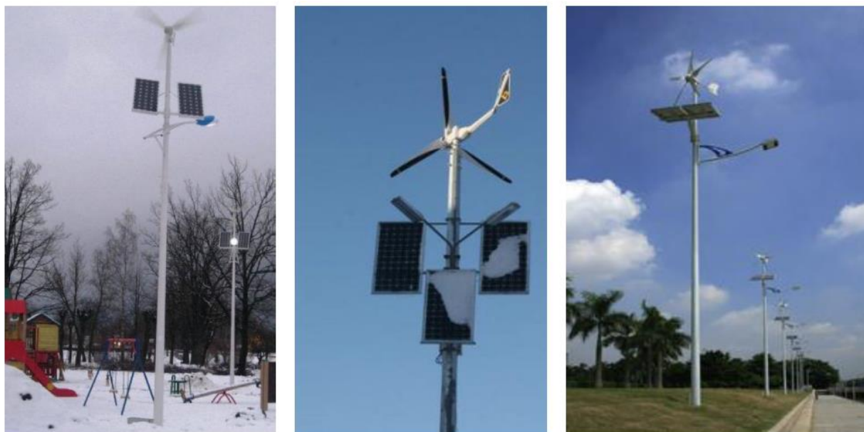
Рисунок 1- Внешний вид ветросолнечных осветительных устройств
