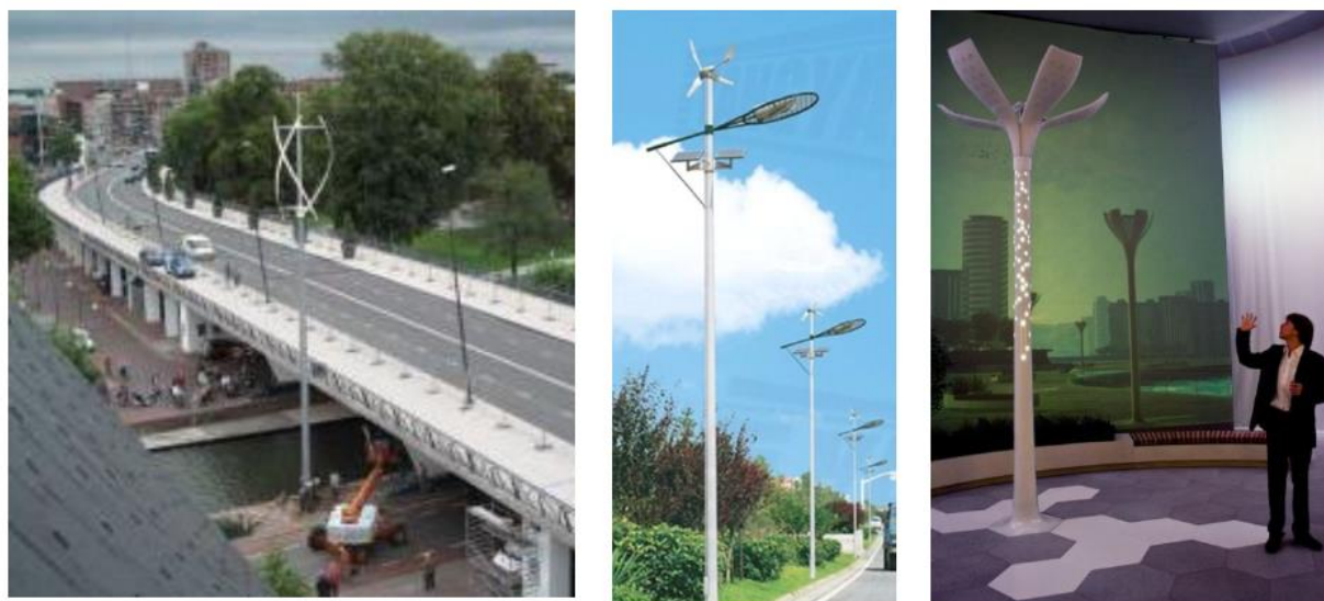
Рисунок 2 - Светильники наружного освещения с использованием ВИЭ
