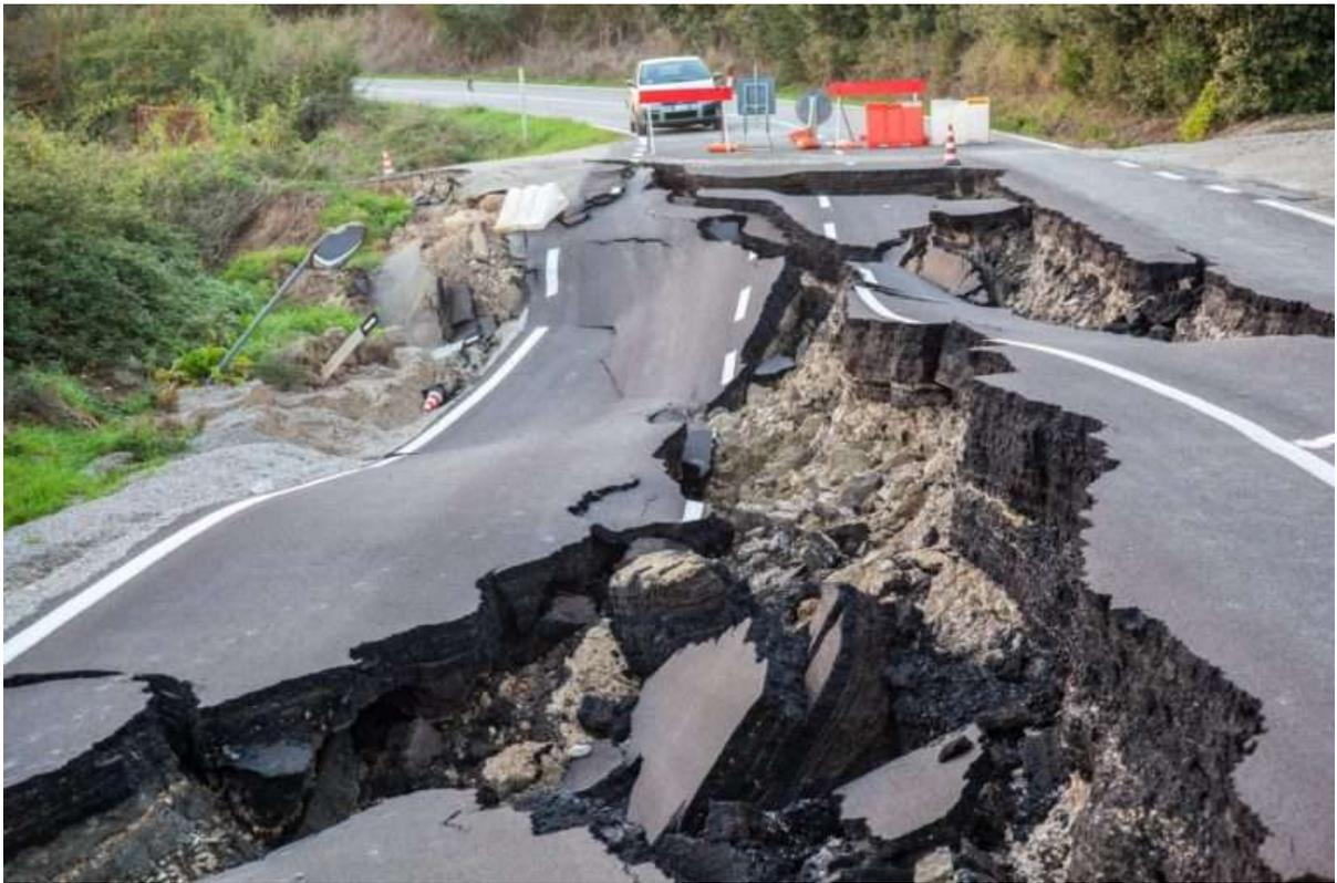
Рисунок 2 – Разрушение дорожного покрытия
