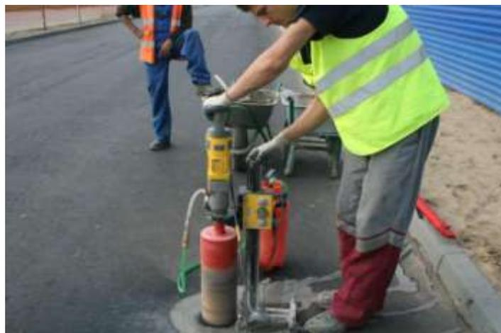
Рисунок 1 – Проверка качества дорожного покрытия
