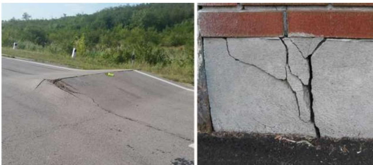
Рисунок 1 – Разрушение инженерных сооружений от действия морозного пучения
