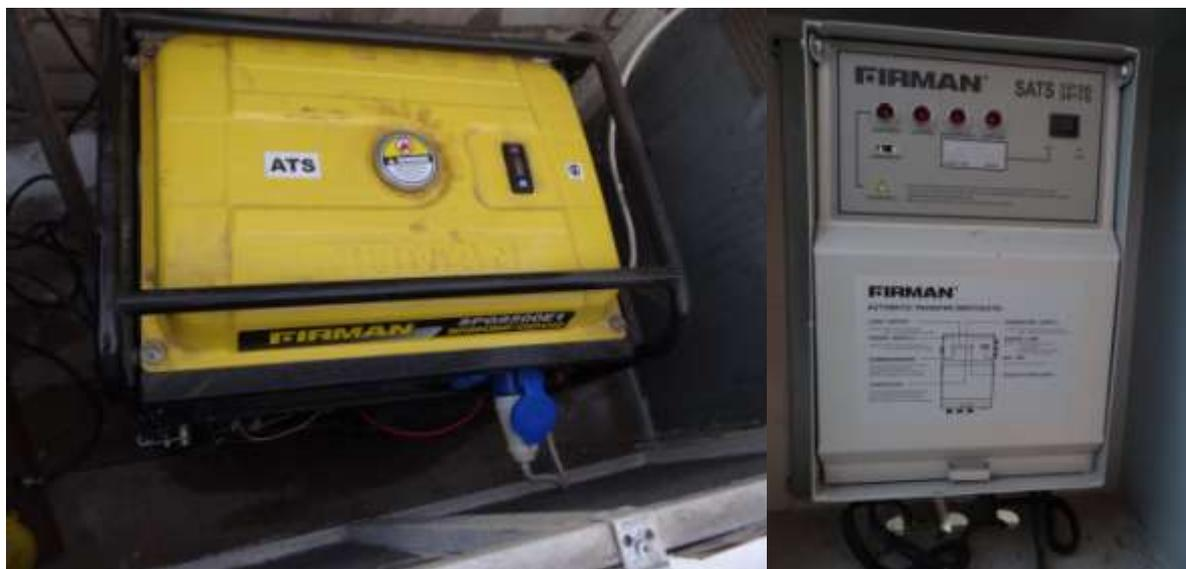
Рисунок – Бензиновый генератор и автомат ввода резерва
