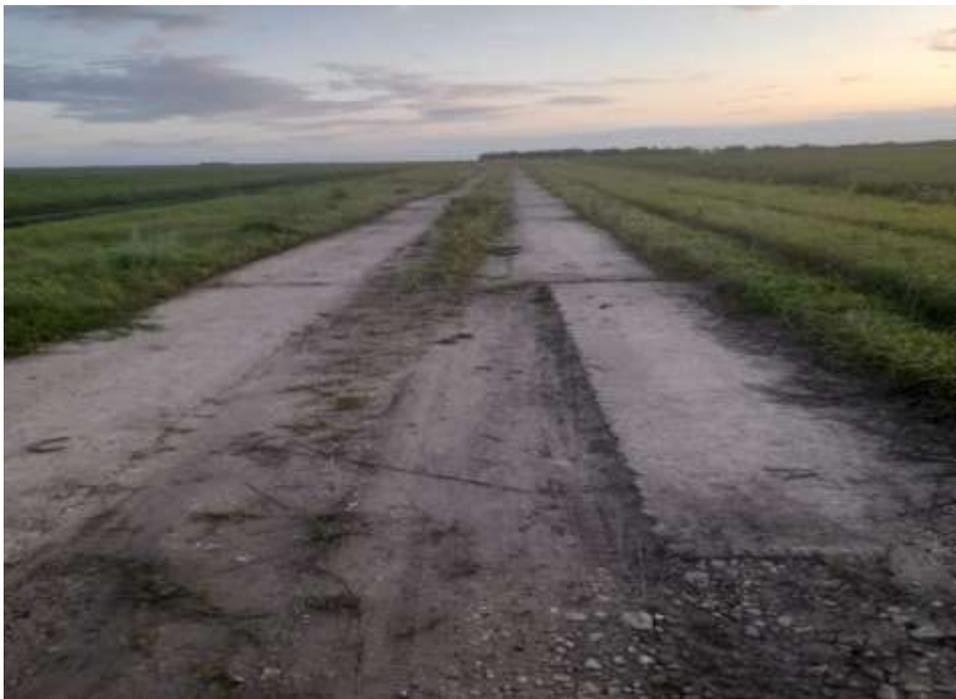
Рисунок 3 – Покрытие из бетонных плит
