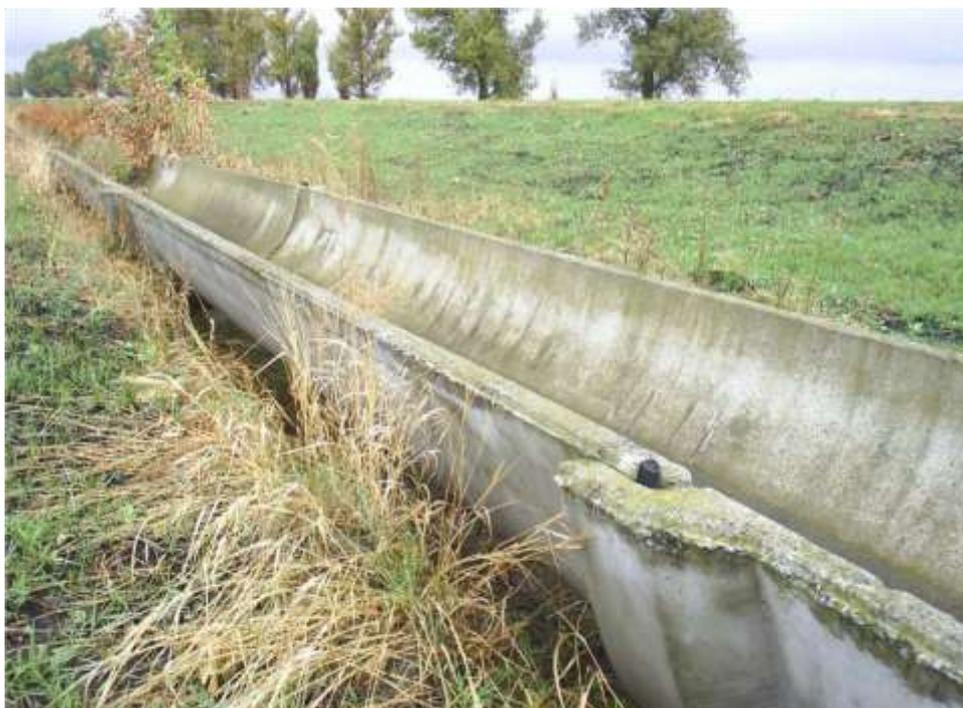
Рисунок 2 – Внутрихозяйственный лотковый канал Нижне-Донской оросительно-обводнительной системы
