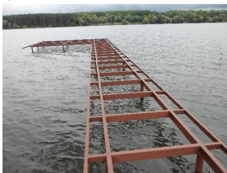
Рисунок 1 – Г-образная форма причала на винтовых сваях
