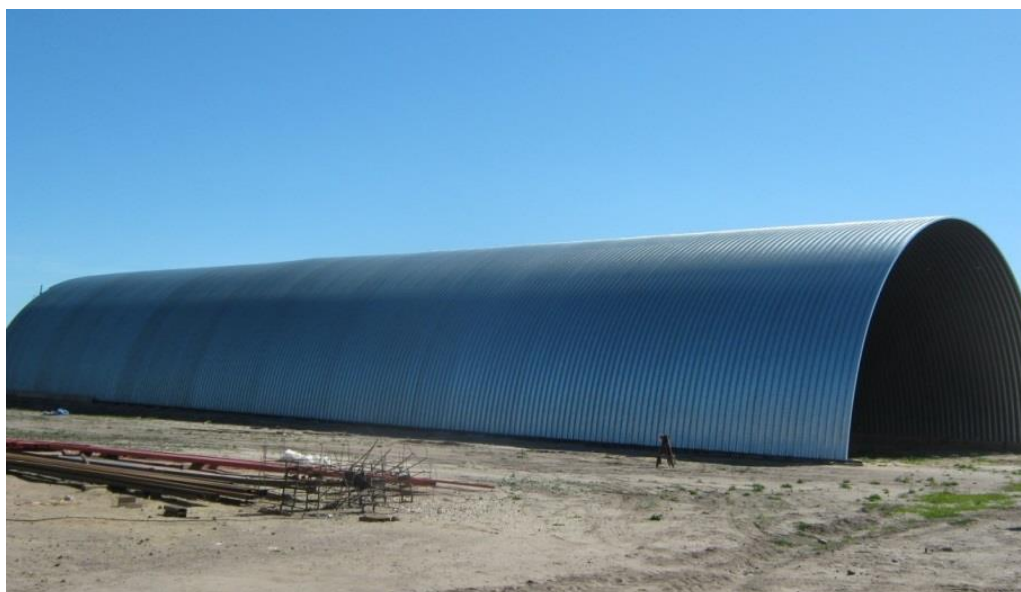
Рисунок 2 – Строящееся бескаркасное картофелехранилище
