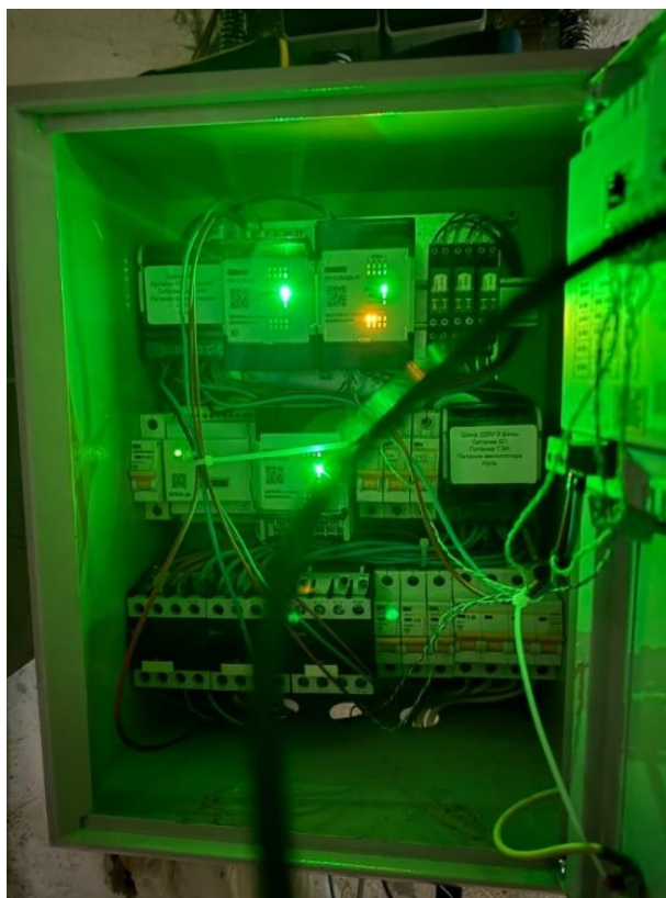
Рисунок 3.4. Щит автоматики, обеспечивающий работу усовершенствованной системы для хранения семенного картофеля
