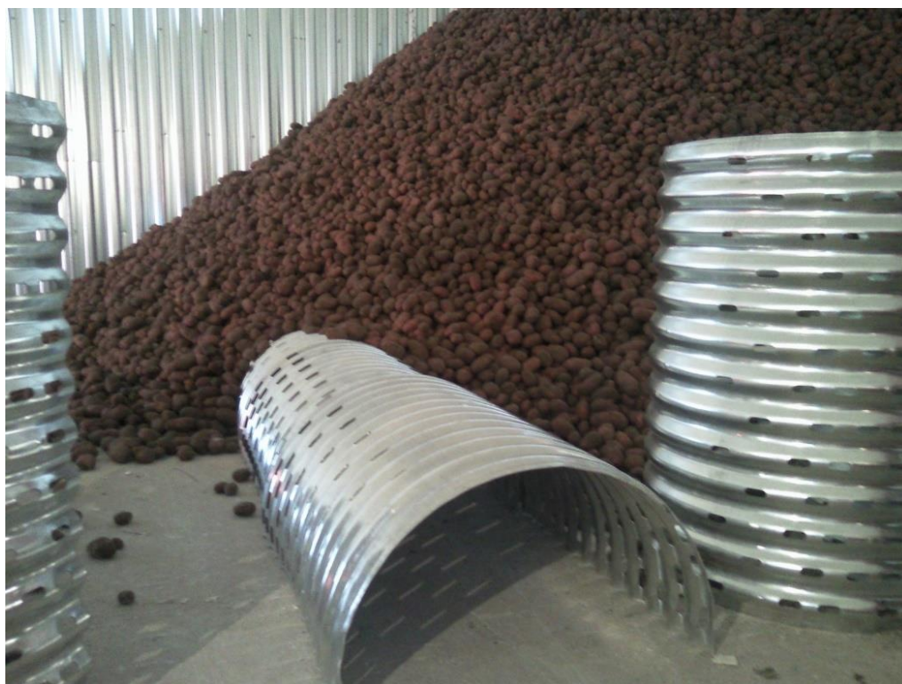
Рисунок 1.4 – Перфорированный напольный канал для вентиляции картофеля
