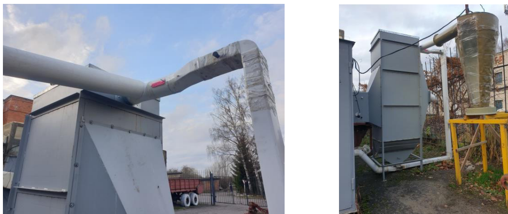
Рисунок 3.20 – Подключение циклона при разгрузке зерна
