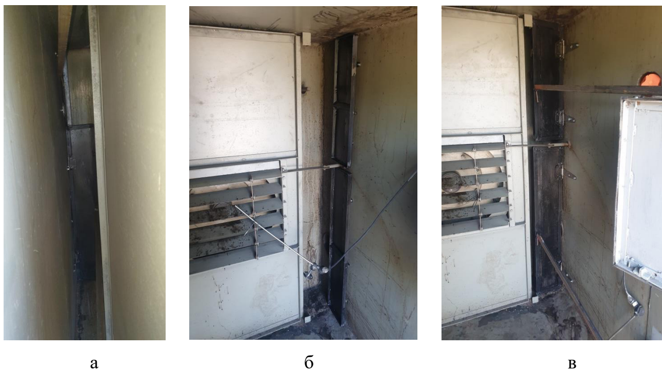
Рисунок 4.12 – Поворотные заслонки: а – левого тракта в положении «закрыто»; б – правого тракта в положении «открыто» (стенка тракта снята); в - правого тракта в положении «закрыто» (стенка тракта снята)
