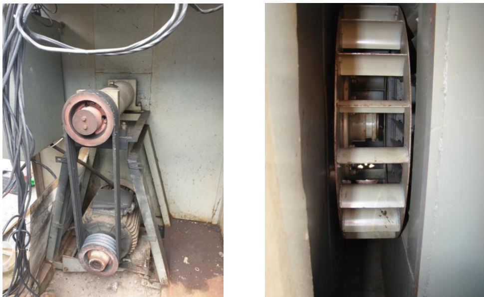
Рисунок 3.23 – Привод ротора-нагревателя (по Исаеву С.Х.) [38]
