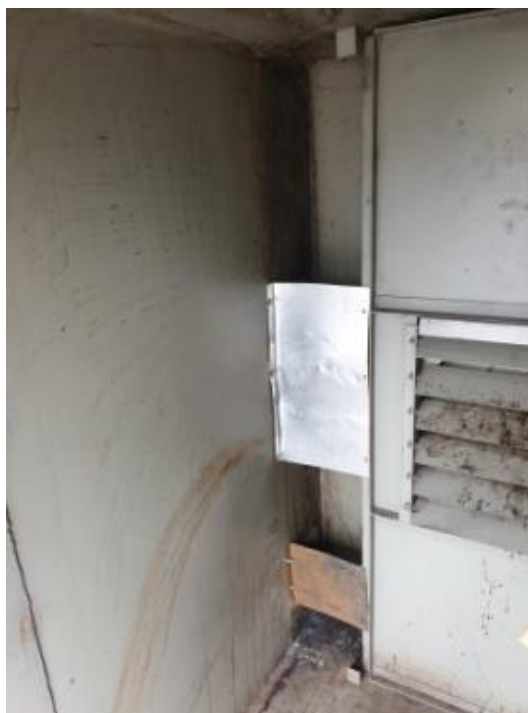
Рисунок 4.10 – Установка отсекателей воздушного потока
