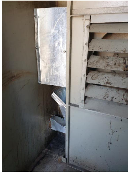
Рисунок 4.10 – Установка воздухозаборника пневмотранспортера
